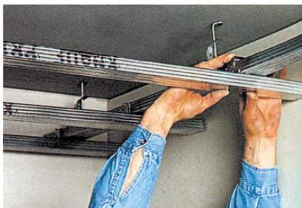
крытые стыки имеют выступы и выемки, чем напоминают дощатую вагонку — покрытие, которое вот уже многие десятилетия используется в деревянном домостроении. Только здесь рейки металлические.
